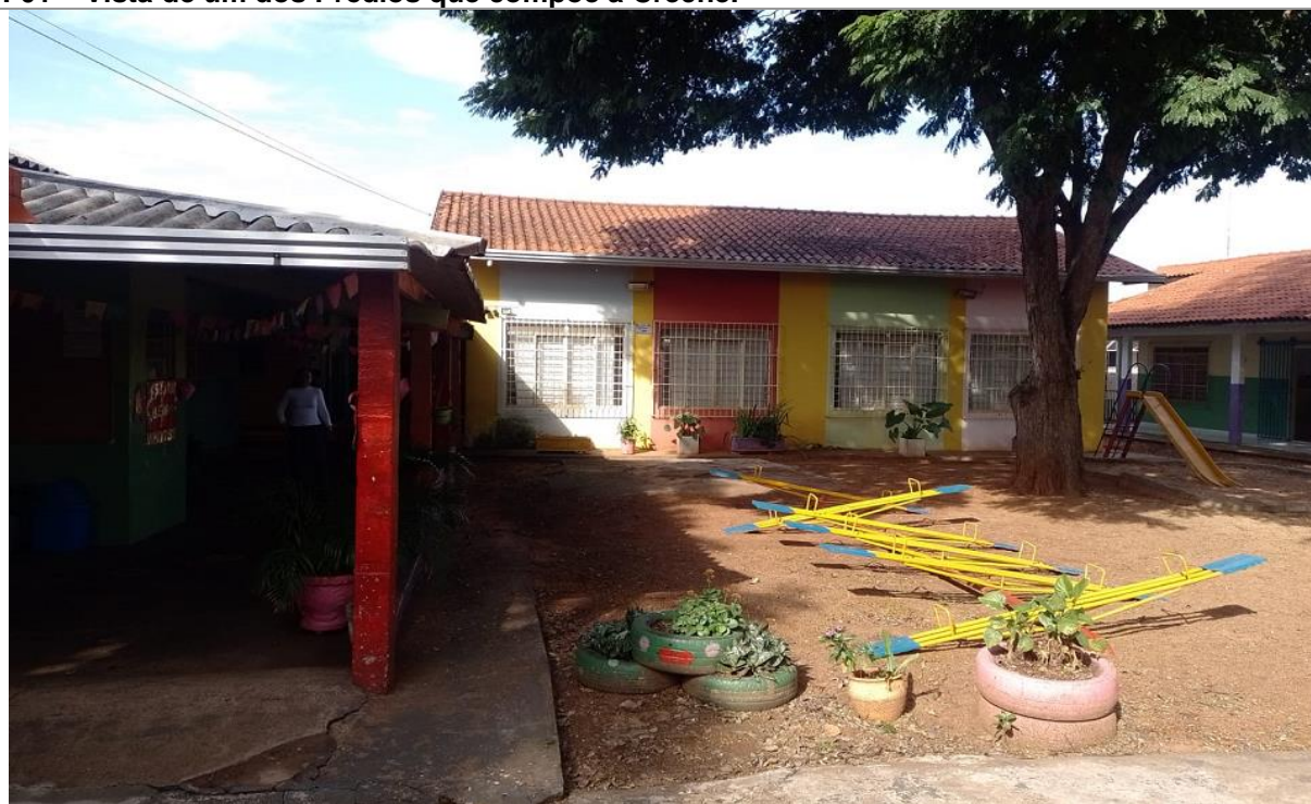
F02- Vista da Entrada da Creche
