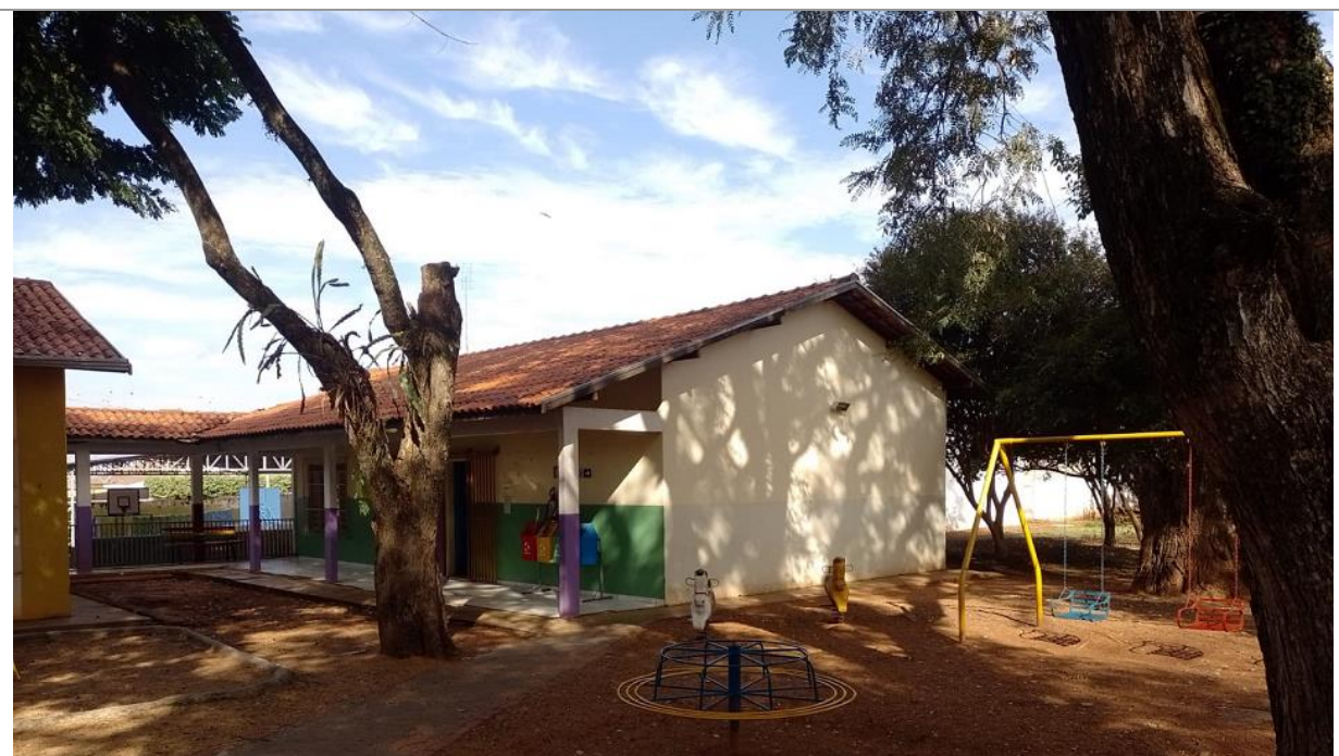
F01 – Vista de um dos Prédios que compõe a Creche.
