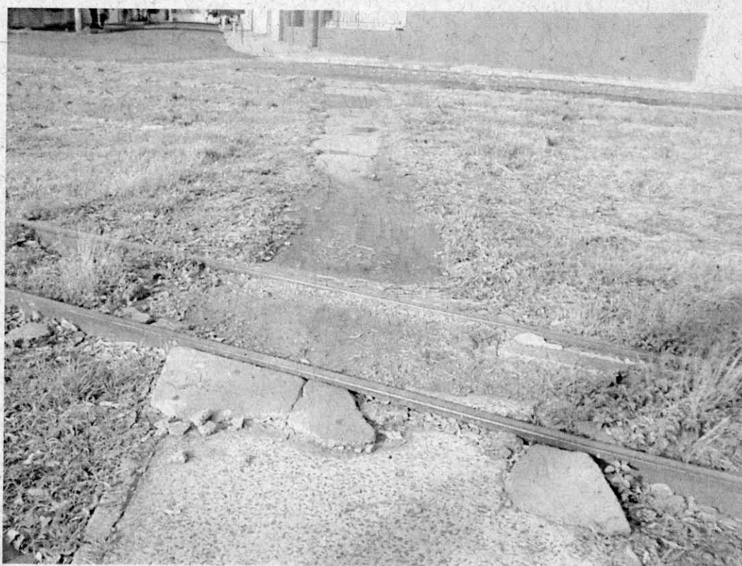
Passarela que liga a Rua Raposo Tavares (Jardim Panambi) com a Rua Goiânia (Vila Priant)
