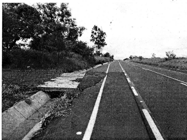
Acesso na SP 421 com viabilidade para servir de passagem à escola e associação dos produtores.
