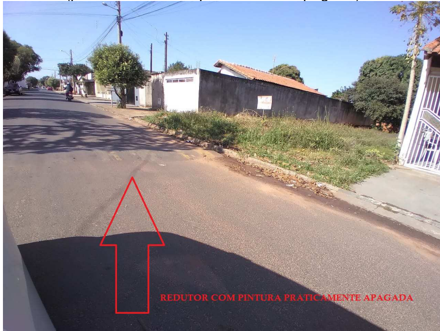
Foto 01: (pintura do redutor praticamente apagada)
