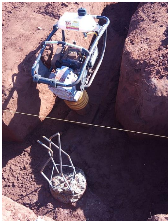
F07 – COMPACTAÇÃO DO FUNDO DA VALA
