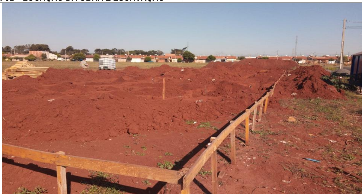
F02- EXECUÇÃO DE GABARITO LOCAÇÃO E ESCAVAÇÃO
