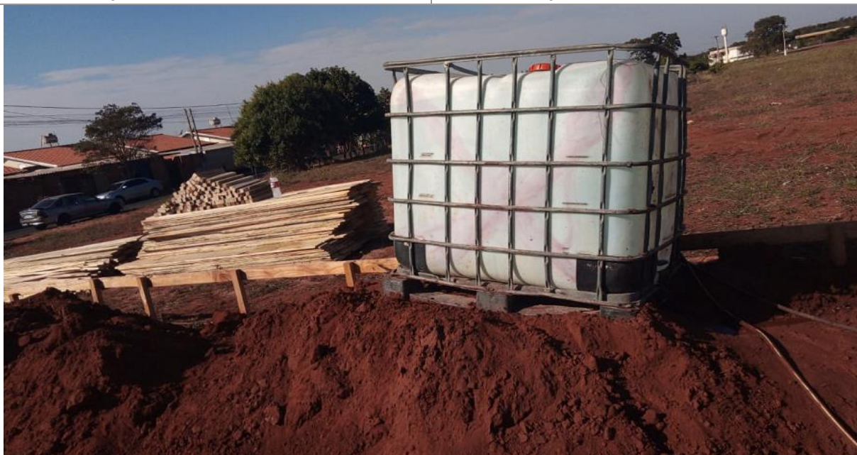
F06 CONTAINER DE ÁGUA P/UMEDECER SOLO E PREPARO PARA INÍCIO DE FORMAS
