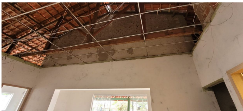
imagem 9 – Retirada do forro PVC
