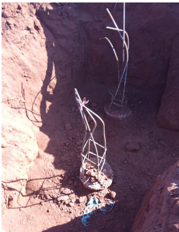
F06-. ESTACA ESCADA E CONCRETADA
