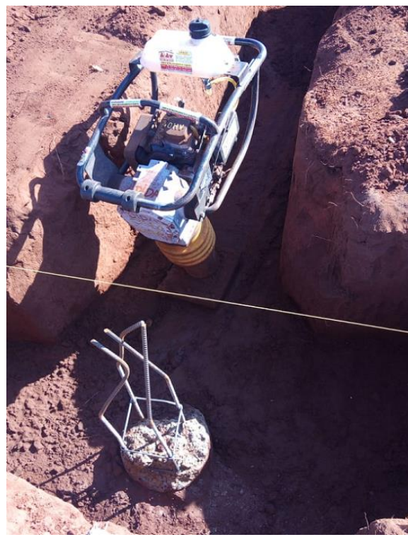
F07 – COMPACTAÇÃO DO FUNDO DA VALA
