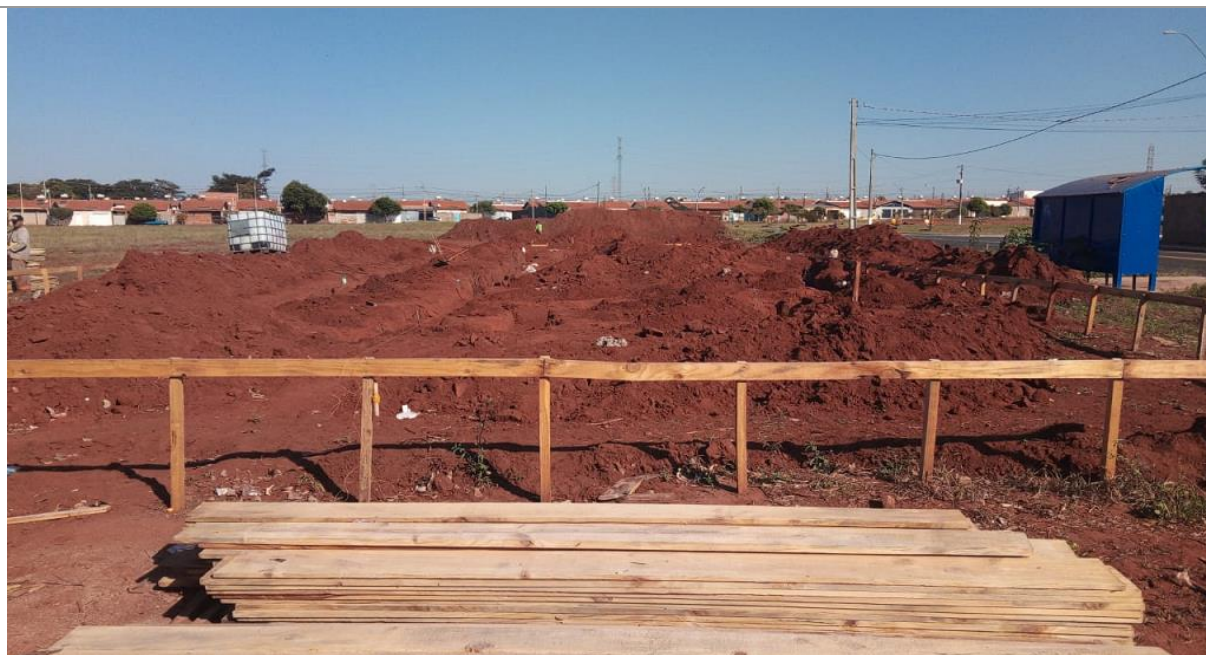
F01 – LOCAÇÃO DA OBRA E ESCAVAÇÃO
