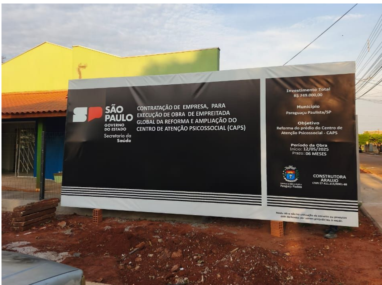
gem 11 – Placa da obra
