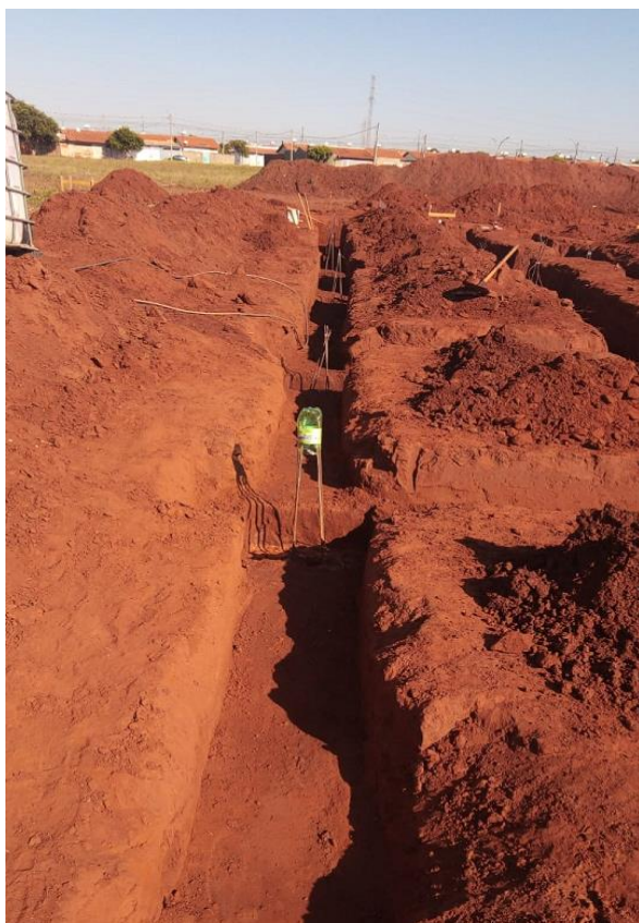
F04.EXECUÇÃO DE ESTACAS ESCAVADAS
