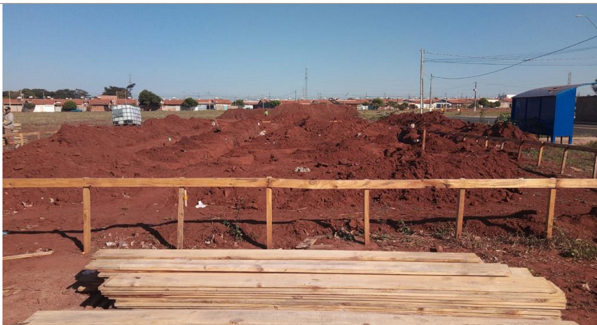
F01 – LOCAÇÃO DA OBRA E ESCAVAÇÃO
