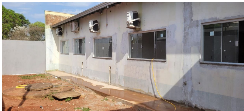
imagem 06 – Janelas, entrada para ar condicionado, fundo preparador nas paredes
