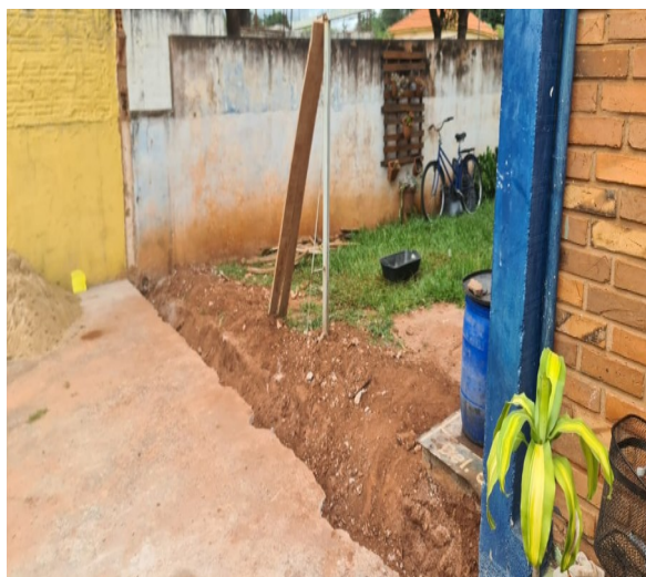
DEMOLIÇÃO DE MURO
