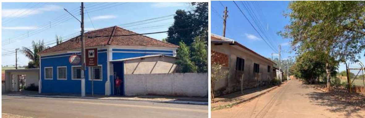
Figura 53: Tipologia das ruas, travessas e edificações do Distrito Conceição com destaque para o Tear Dona Pureza na primeira imagem e assentamento precário respectivamente.
