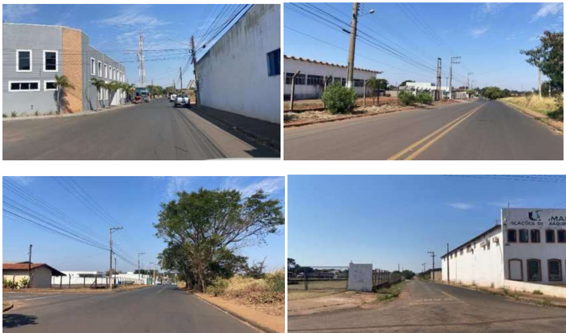
Figura 41: Distrito Industrial, com presença de muitos lotes vazios
