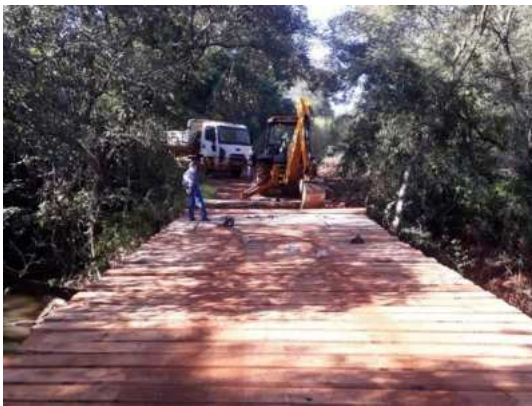
Figura 78: Ponte reformada em julho de 2022 sobre o Rio Capivara na PGP-180
