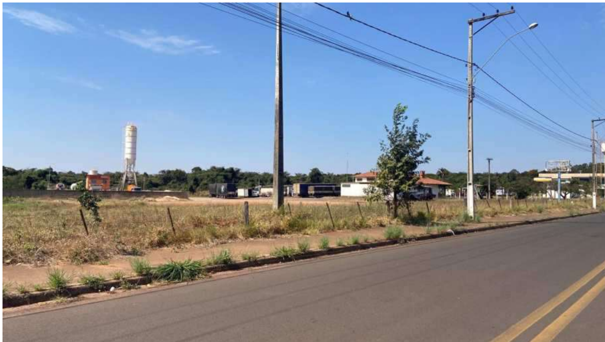
Figura 43: Eixo entre a Avenida Siqueira Campos eixo em direção rodovia Manílio Gobbi/ SP- 284: presença de grandes galpões de prestação de serviços
